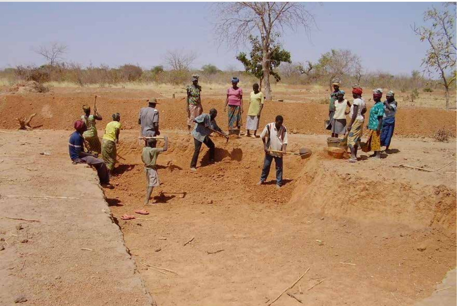
Construction d'un Bulli à déversoir, pour permettre l'infiltration des eaux vers la nappe phréatique et protéger la route
